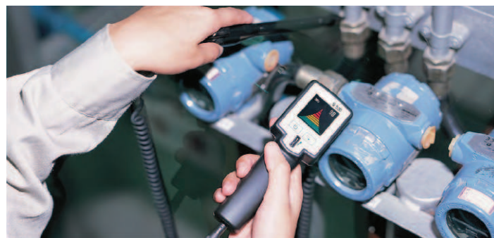
Detección de fugas con punta de enfoque
